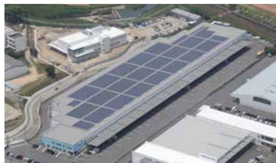
IIF鳥栖ロジスティクスセンター
