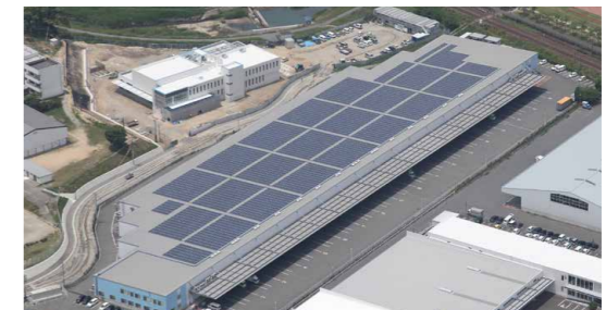
IIF鳥栖ロジスティクスセンター
