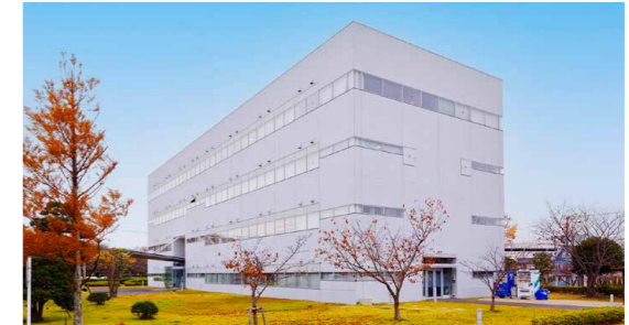
IIF横須賀テクノロジーセンター
