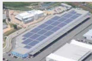
IIF鳥栖ロジスティクスセンター
