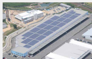
IIF鳥栖ロジスティクスセンター
