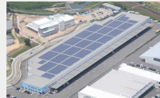
IIF鳥栖ロジスティクスセンター
