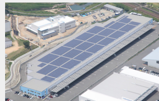
IIF鳥栖ロジスティクスセンター
