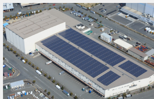
IIF神戸ロジスティクスセンター
